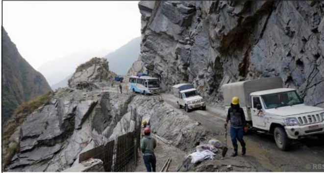
काठमाडौंमा 'एक एड्रिड' गरेर सडक फराकिलो पारिँदै: बेनी-जोमसोम-कोरला सडक योजना अन्तर्गत म्यादीको अन्नपूर्ण गाउँपालिका-३ मा पनो काभ्रेभेरीमा 'एक एड्रिड' (पहाडमा पारेको च्यालमा रड राखेर सिमेन्ट, बालुवा र मिट्टी जमाउने प्रविधि)बाट सडक फराकिलो पारिँदै। डोजर, बेकर र बिस्कोट पवारको प्रयोग गर्दा पहाड चर्किएर खस्ने जोखिम देखिएपछि डिलतर्फको पहाडमा एक एड्रिड गर्ने प्रविधि अपनाइएको हो। तस्वीर: सन्तोष गौतम/रासस
